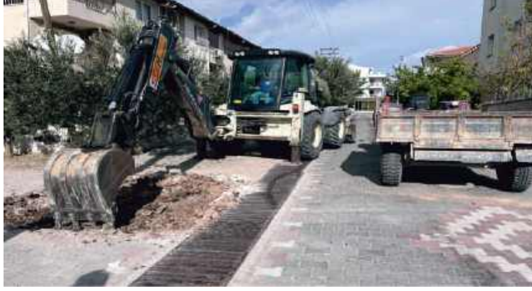
36-Çandarlı Mahallesi 105 Sokak Yol Yapım İşi.
