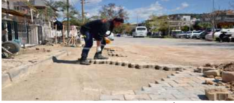
32- Cumhuriyet Mahallesi 441 Sokak Yol ve Kaldırım Yapım İşi.
