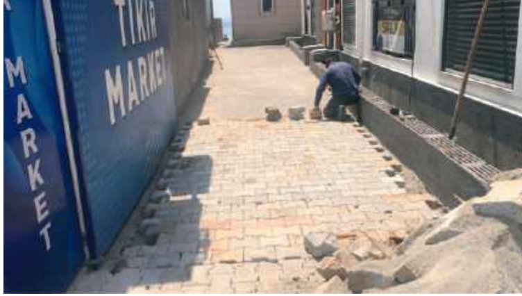
40-Çandarlı Mahallesi 116 Sokak Yol Yapım İşi.
