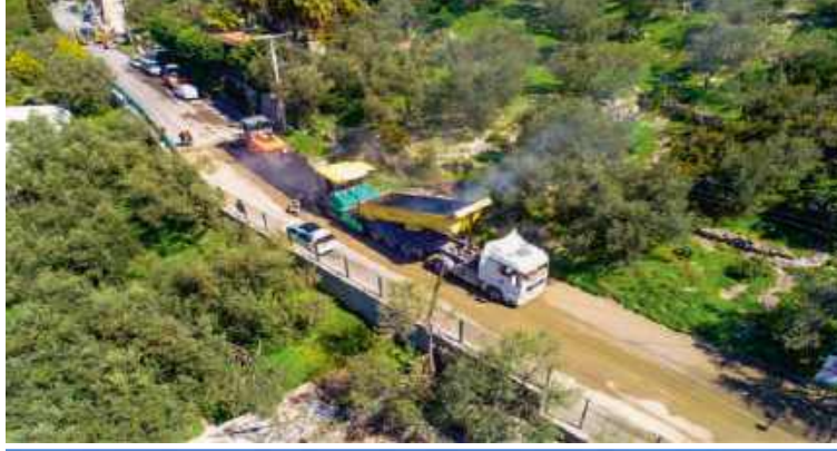
14- Bademli-Denizköy Yolu Yol Yapım İşi.
