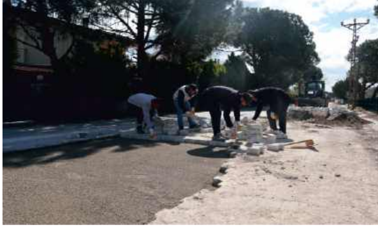
92- Salimbey Mahallesi 12 Sokak Yol Yapım İşi.
