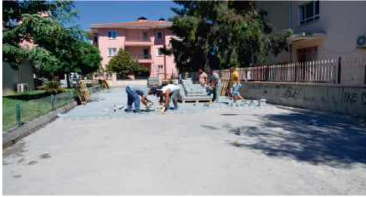
25- Cumhuriyet Mahallesi 310 Sokak Yol Yapım İşi.
