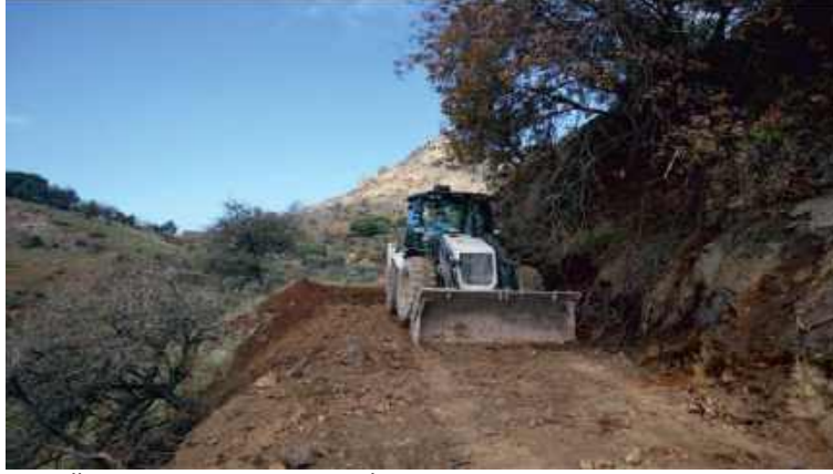
85- Kızılcukur Mahallesi Üretim Yolu Yapım İşi.
