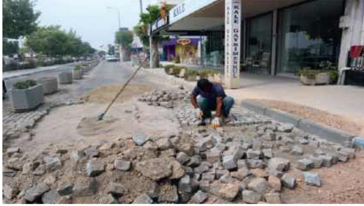
44-Çandarlı-Denizköy Yolu Yol Yapım İşi.
