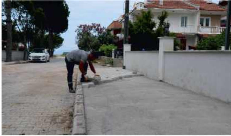
33- Cumhuriyet Mahallesi Uğur Mumcu Caddesi Kaldırım Yapım İşi.
