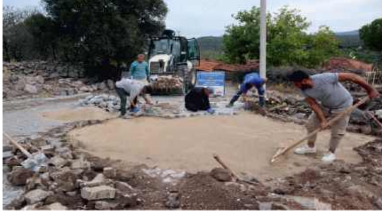
84- Kıratlı Mahallesi Üretim Yolu Yapım İşi.
