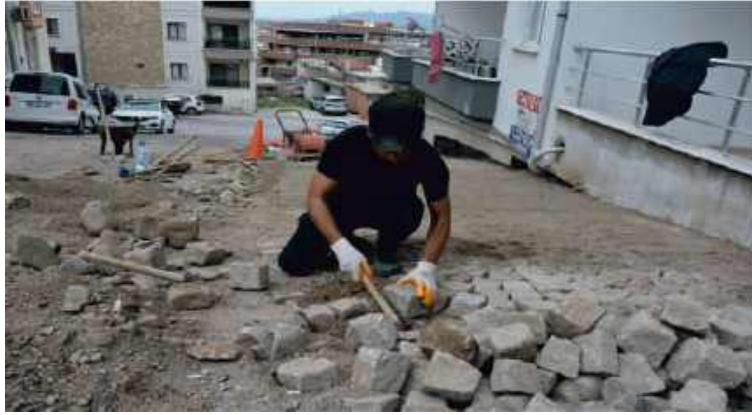
73- İsmetpaşa Mahallesi 56-3 Sokak Yol Yapım İşi.
