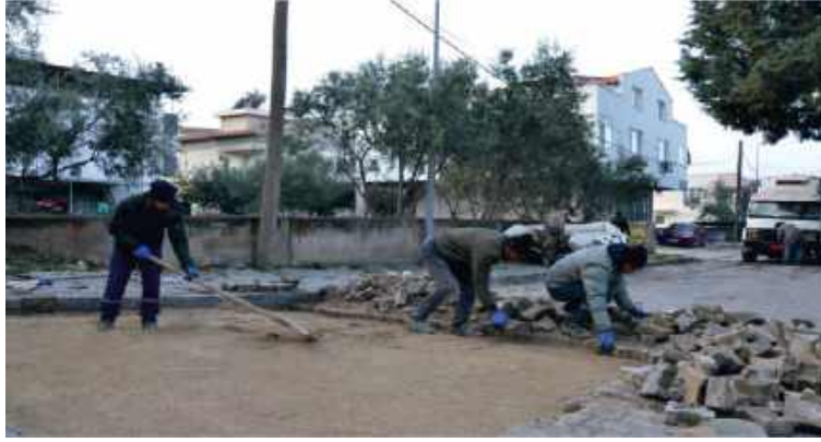
69- İsmetpaşa Mahallesi 3 Sokak Yol Yapım İşi.
