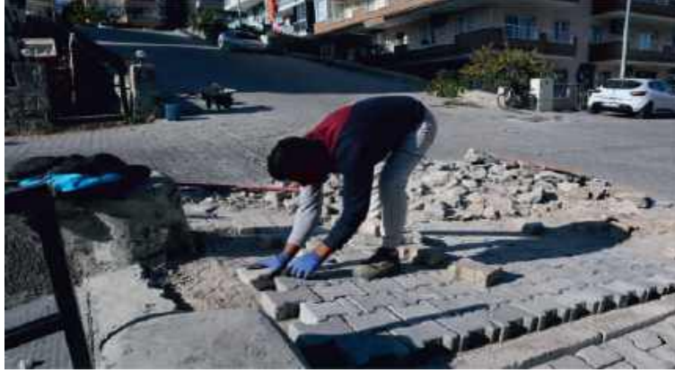
61- Gazipaşa Mahallesi 57-1 Sokak Yol Yapım İşi.
