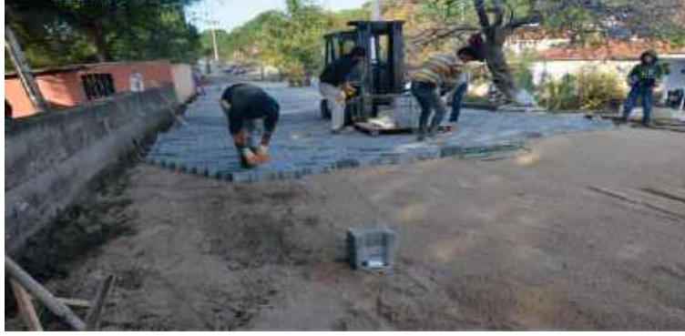
20- Bahçeli Mahallesi Üretim Yolu Yol Yapım İşi.
