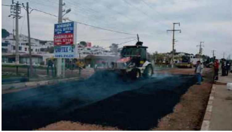
45-Çandarlı Mahallesi Dikili Belediyesi Ek Hizmet Binası Çevre Düzenlemesi ve Yol Yapım İşi.
