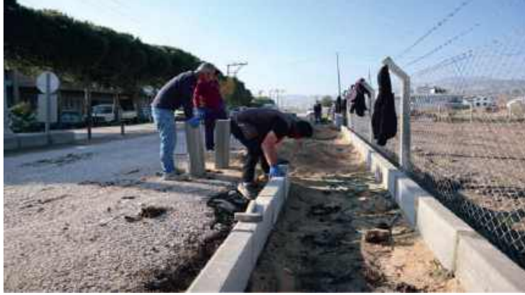
48- Çandarlı Mahallesi Kara Halil Paşa Caddesi Yol ve Refüj Yapım İşİ.
