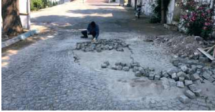
56- Çandarlı Yeşil Sokak Yol Yapım İşi.
