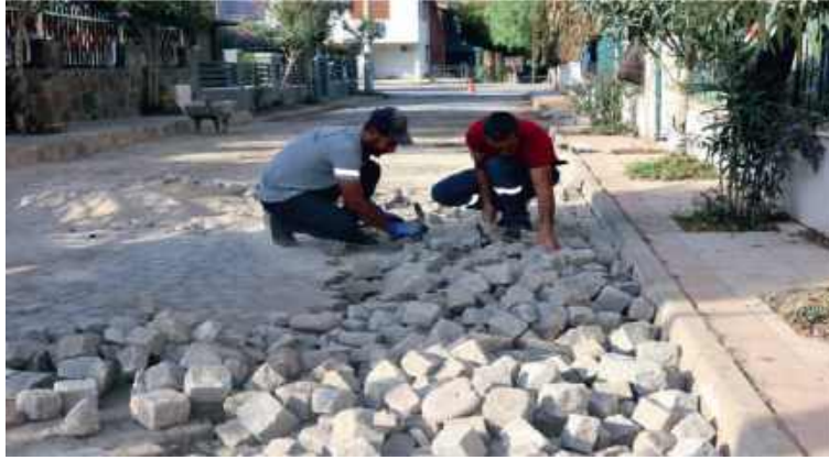
29- Cumhuriyet Mahallesi 379-1 Sokak Yol Yapım İşi.
