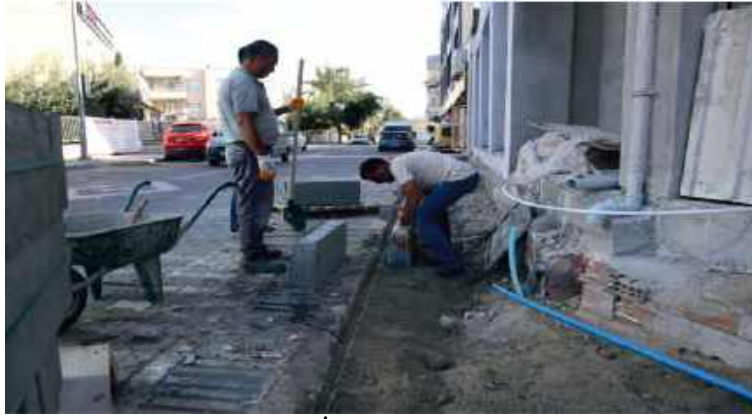
49- Çandarlı Mahallesi Mavikent Yol Yapım İşİ.
