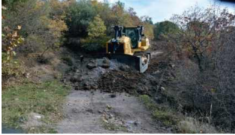
88- Merdivenli Mahallesi Yol Yapım İşi.
