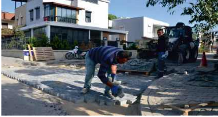
24- Cumhuriyet Mahallesi 309 Sokak Yol Yapım İşi.
