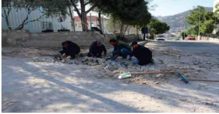
97-Salimbey Mahallesi Barışkent 108 Sokak Yol Yapım İşi
