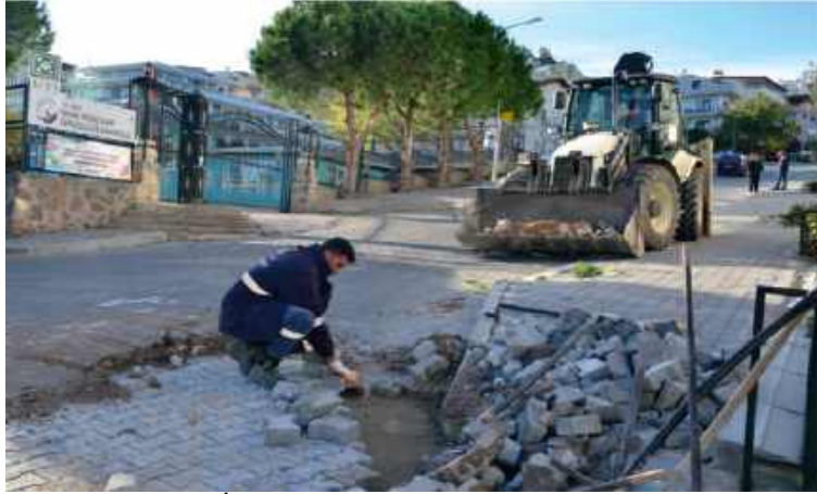
65- Gökçeagıl Mahallesi Yol Yapım İşi.
