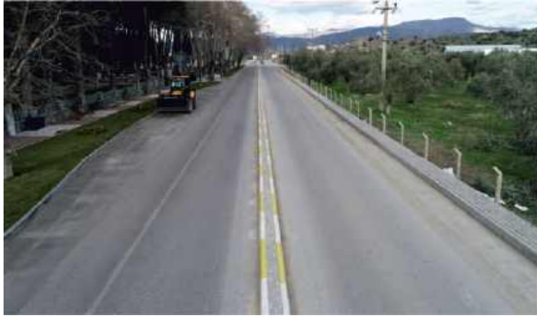
12- Bademli Mahallesi 1 Sokak Yol Yapım İşi.
