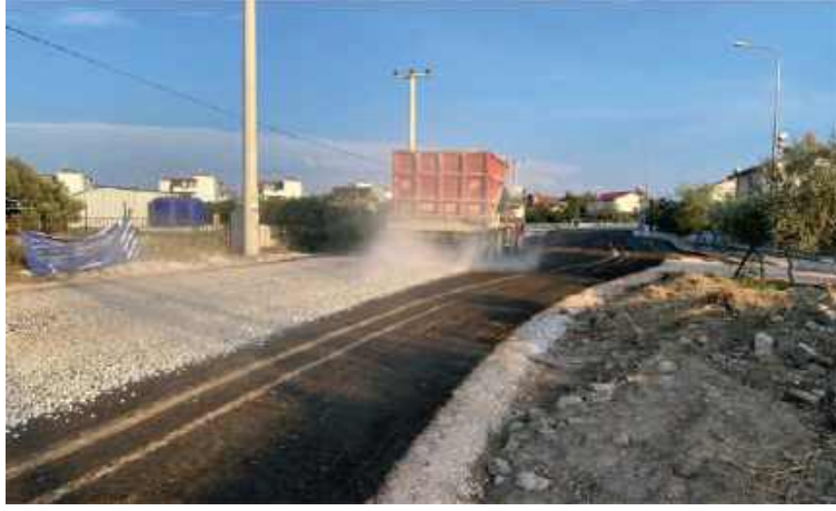
21- Cumhuriyet Mahallesi 302 Sokak Yol Yapım İşi.
