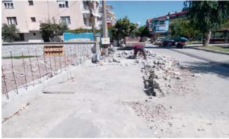
37-Çandarlı Mahallesi 106 Sokak Yol Yapım İşi.
