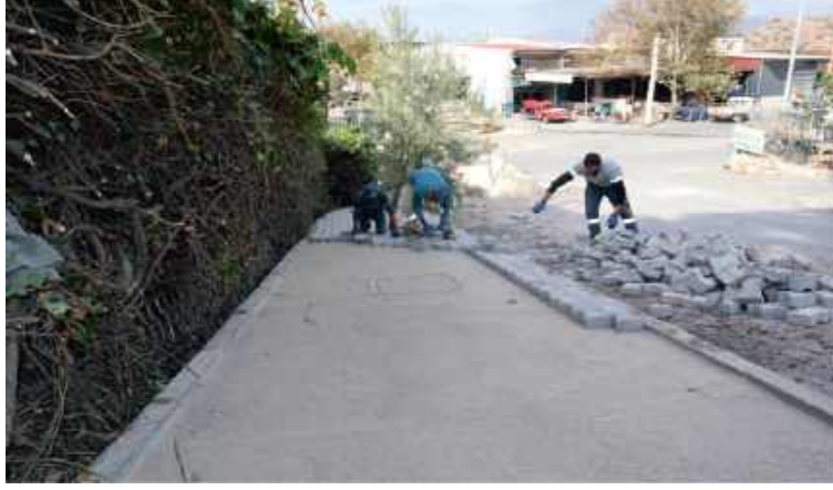
76- İsmetpaşa Mahallesi 95 Sokak Yol Yapım İşi.
