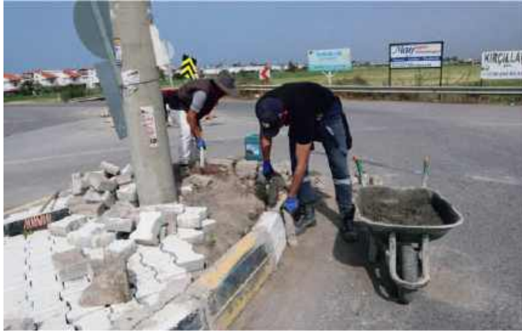
81- Kabakum Mahallesi Yol Yapım İşi.
