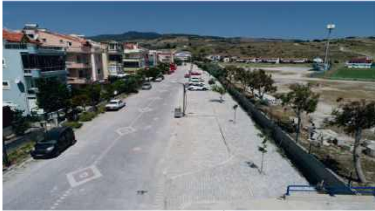
53- Çandarlı Mahallesi Sucu Hafız Caddesi Yol Yapım İşi.
