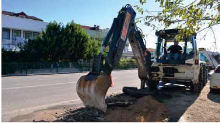
52- Çandarlı Mahallesi Stadyum Çevresi Yol ve Kaldırım Yapım İşi.
