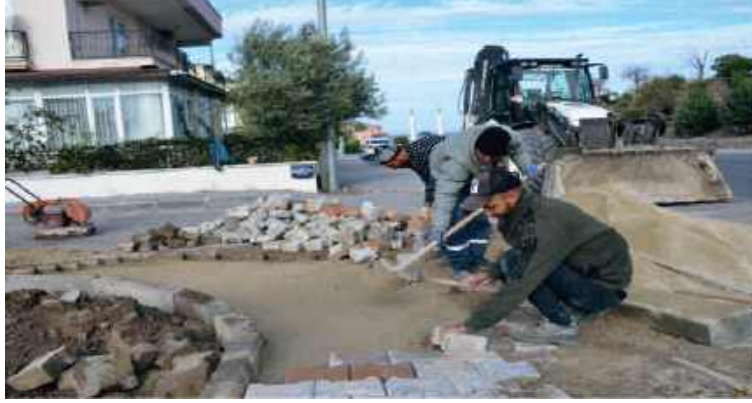
64- Gazipaşa Mahallesi 75. Yıl Caddesi Yol Yapım İşi.
