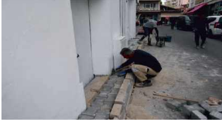
93- Salimbey Mahallesi 17 Sokak Yol Yapım İşi.
