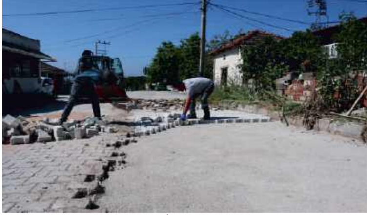
68- İsmetpaşa Mahallesi 1-1 Sokak Yol Yapım İşi.
