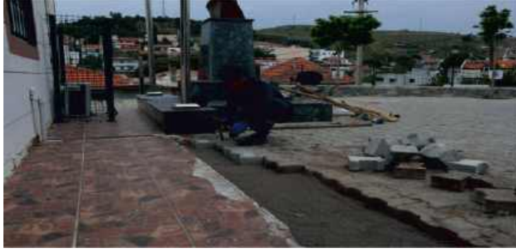
70- Kabakum Mahallesi Refüj Yapım İşi.
