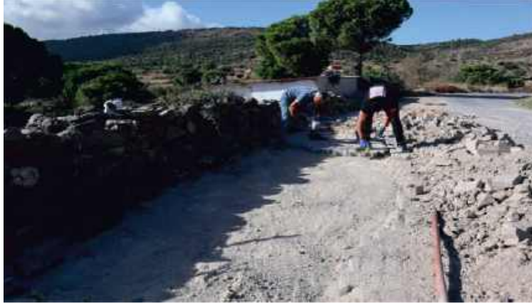
60- Gazipaşa Mahallesi 55-1 Sokak Yol Yapım İşi.
