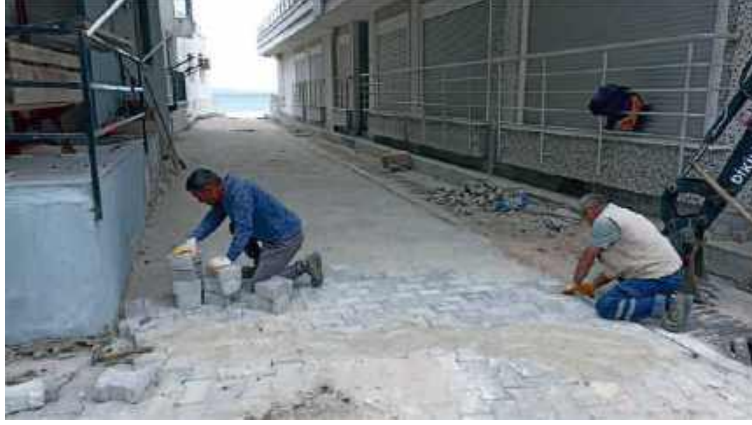
41-Çandarlı Mahallesi 139 Sokak Yol Yapım İşi.
