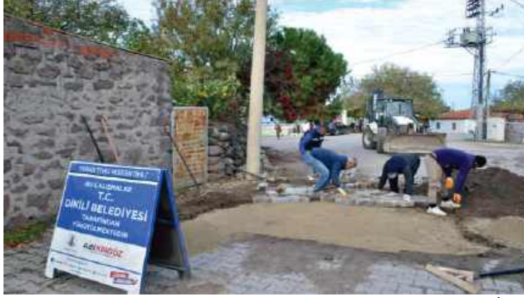
89- Salimbey Mahallesi Muammer Aksoy Parkı Çevre Düzenlemesi Yapım İşi.
