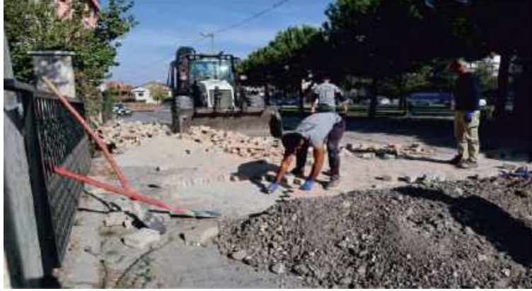
28- Cumhuriyet Mahallesi 369 Sokak Yol Yapım İşi.
