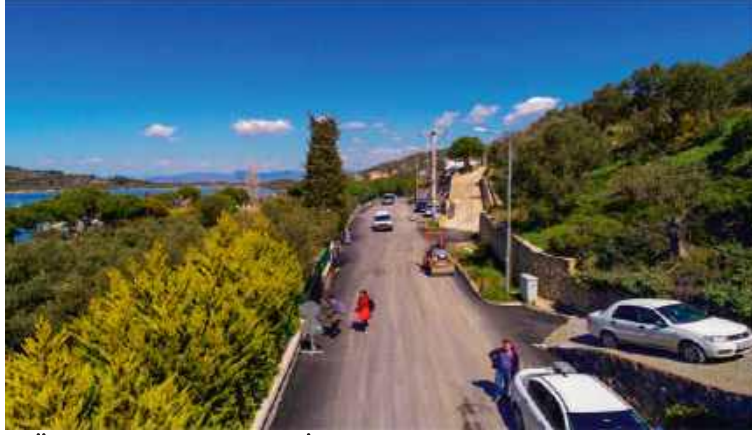
15- Bademli Mahallesi Üretim Yolu Yapım İşi.
