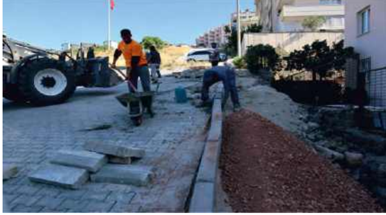
96- Salimbey Mahallesi 116 Sokak Yol Yapım İşi
