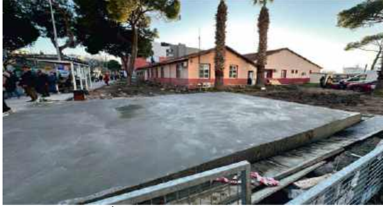
101-Uzunburun Mahallesi Yol Yapım İşi
