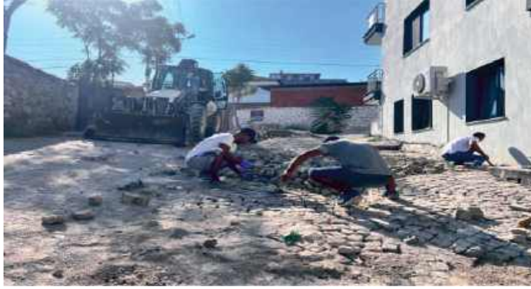
72- İsmetpaşa Mahallesi 54-1 Sokak Yol Yapım İşi.
