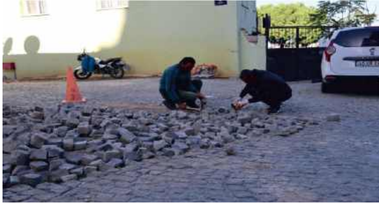
77- İsmetpaşa Mahallesi Sanayi Caddesi Yol Yapım İşi.
