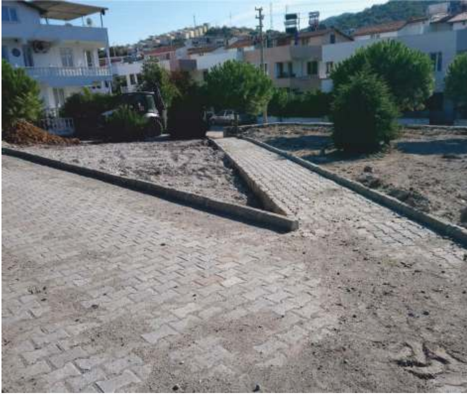
TOPRAK DOLGU ÇALIŞMASI
