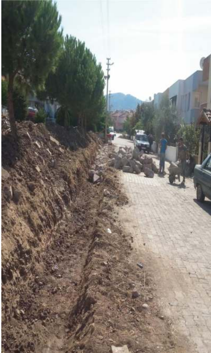
İSTİNAD DUVARI ÖRME ÇALIŞMASI
