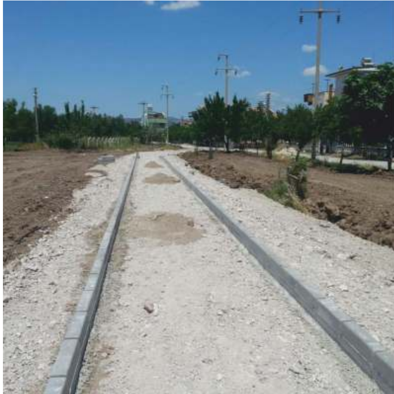
ÖZTOP SİTESİ BORDÜR DÖŞEME
