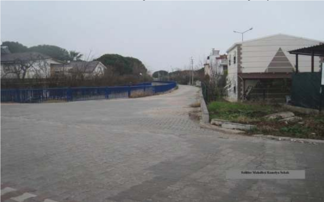
Salihler Mahallesi Kamelya Sokak Kilit Parke Taş Kaplama
