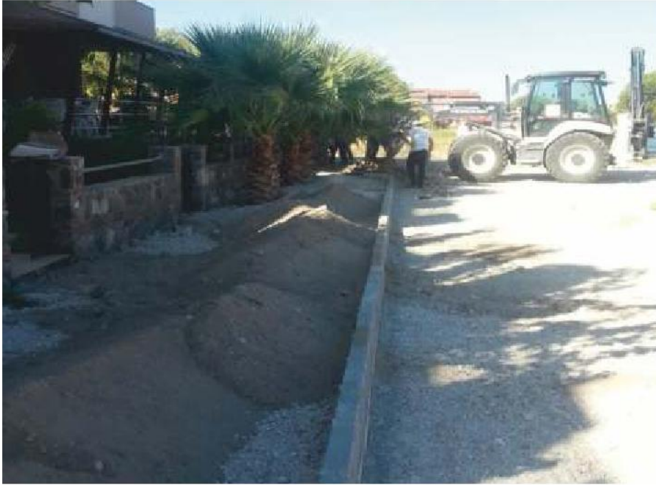
399/1 SOKAK BORDÜR DÖŞEME
