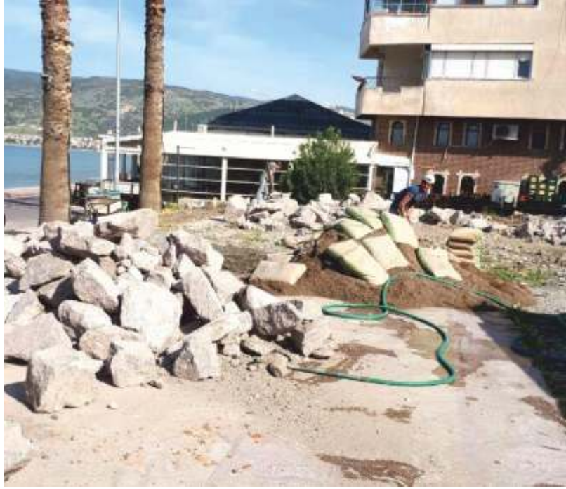
İSTİNAD DUVARLARI ÖRME ÇALIŞMALARI
