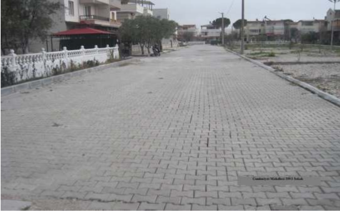
Cumhuriyet Mahallesi 399/1 Sokak Kilit Parke Taş Kaplama
