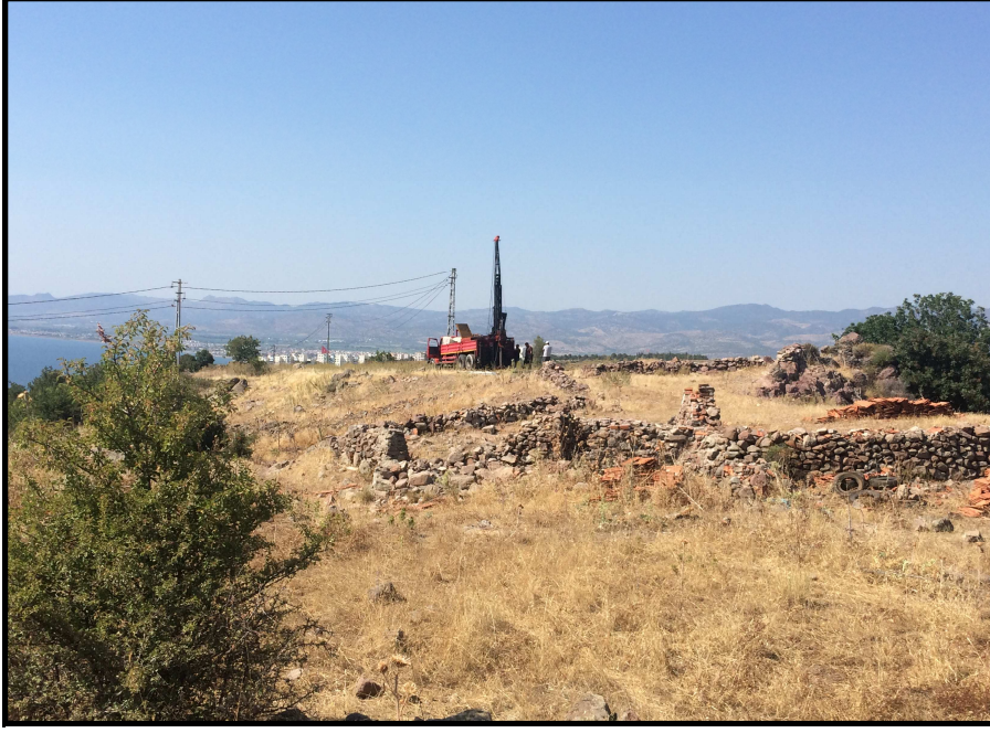
Resim 2 Planlama Alanında yer alan yapılaşmaların genel görünümü 2 (Gür Mühendislik,2021)
